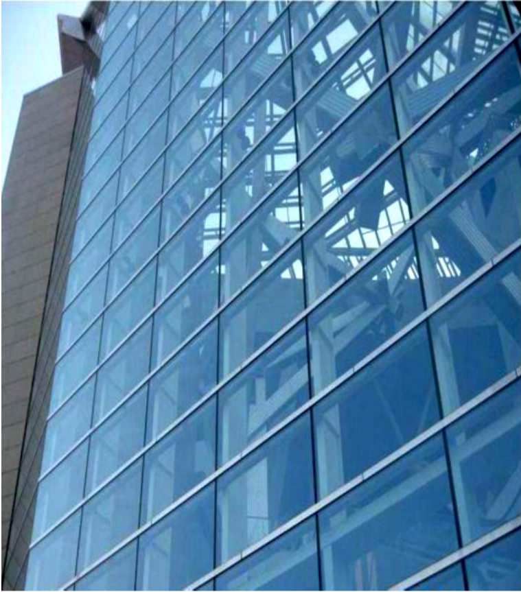
镀膜玻璃幕墙
